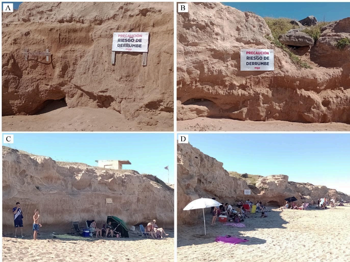
Figura 5. Señalizaciones sobre el peligro de derrumbes (A, B), y usuarios instalados al pie del acantilado (C, D).
