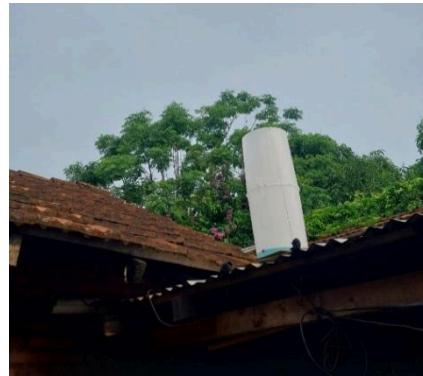
Figura 4. Instalación del colector
