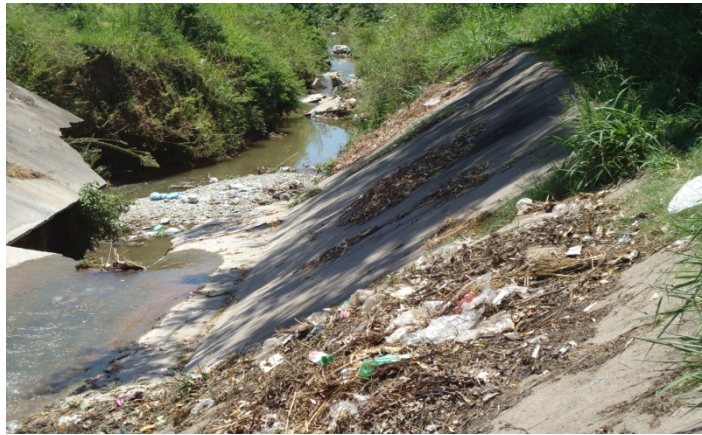
Figura 2: Problemática de vertederos en canales
