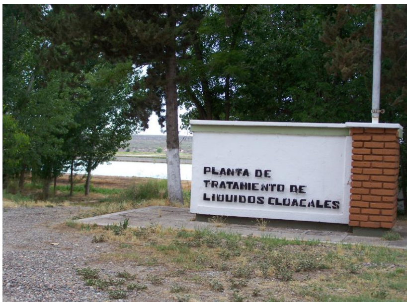
FIGURA 1. Planta de tratamiento de líquidos cloacales en Tunuyán, Mendoza, donde se realizaron experiencias de riego de cultivos energéticos.
