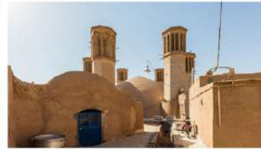
Fig. Un sb ambar con doble cúpula y captadores de viento en Yazd, Irán.
