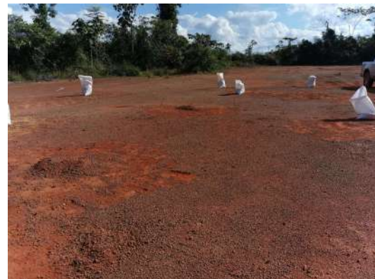
Figura 1. Extracción de grava laterítica Beni – Riberalta (fuente: autor)
