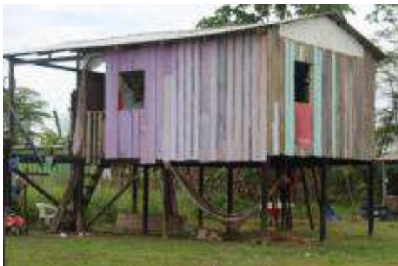
Imagen 03: Casa reconstruida después de la inundación. Fuente: Colección personal.
