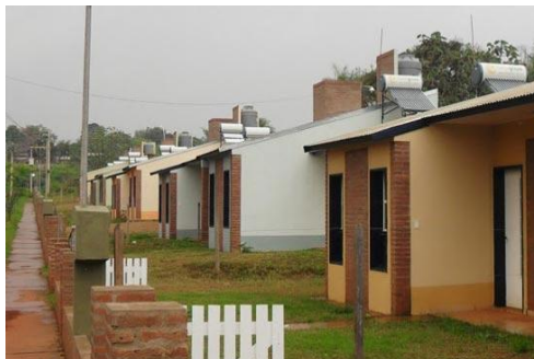
Figura n.º 4. Calefones de tubo de vacío instalados en 40 viviendas sociales en Posadas, Misiones
