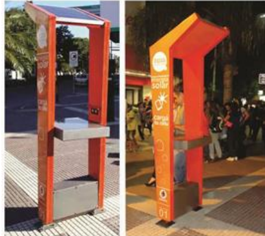
Figura n.º 18. Cargador Solar instalado en la ciudad de Resistencia
