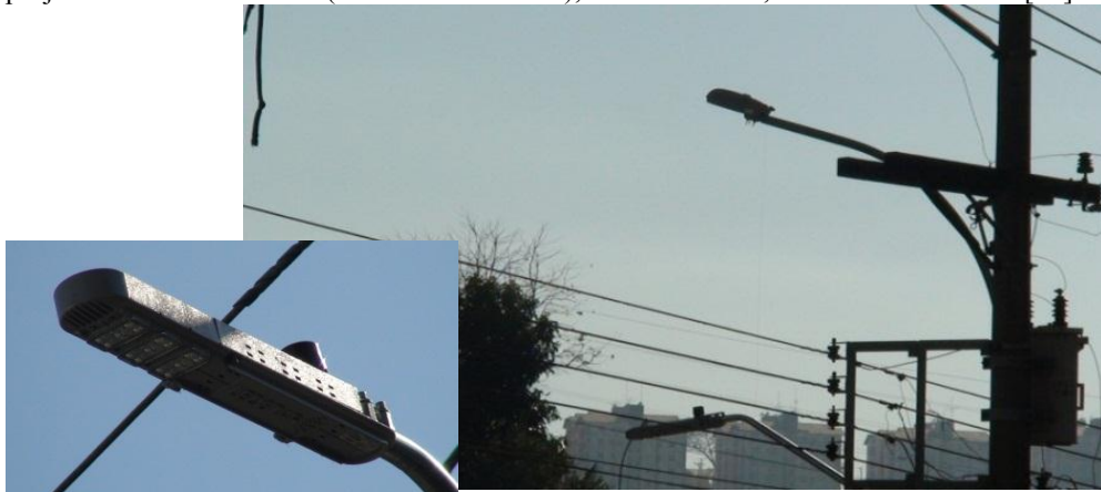
Figura n.º 16. Luminária para LVSAP (acima) e um tipo de luminária instalada durante o projeto “LED nos bairros” (abaixo e no detalhe), em Maio/2016, cidade de São Paulo [12]
