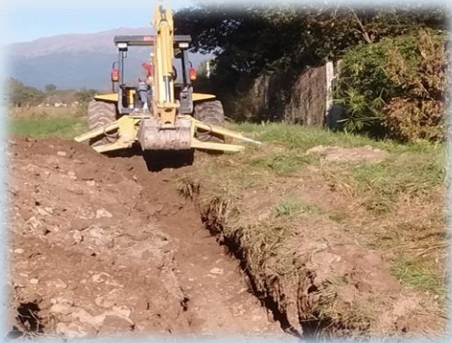
Abertura de zanjas
