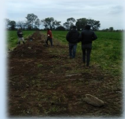
Tapado de zanjas
