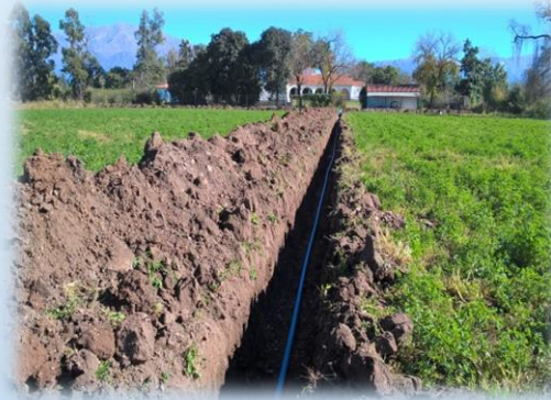
Colocación de caños
